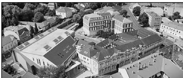
A Lévay épületegyüttese – madártávlatból
